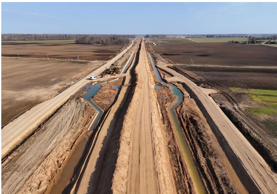
Põitrassi ehitus Leedus. Foto: LTG Infra
