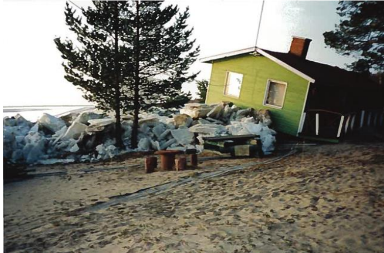
Joonis 4.3.4. Näide triivjää poolt põhjustatud kahjustusest kaldarajatisele.
